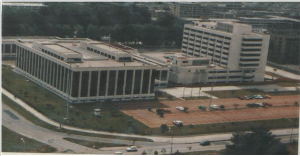
Vista de la etapa final de la realización arquitectónica del Arquitecto Aristides Ramírez Cárdenas
