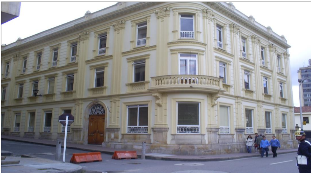
En 1962 funcionó la rama Administrativa en este edificio.
