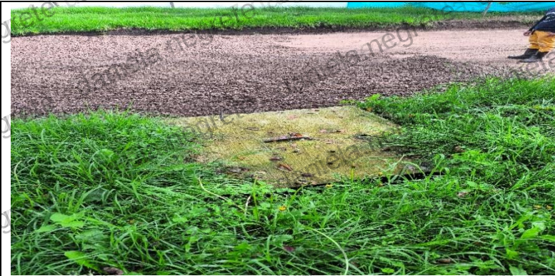
Caja ubicada frente a la edificación CAOFI
